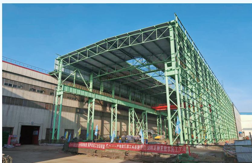
宏宇新材料公司工艺流程优化及产品结构调整项目新建冷轧原料库。
