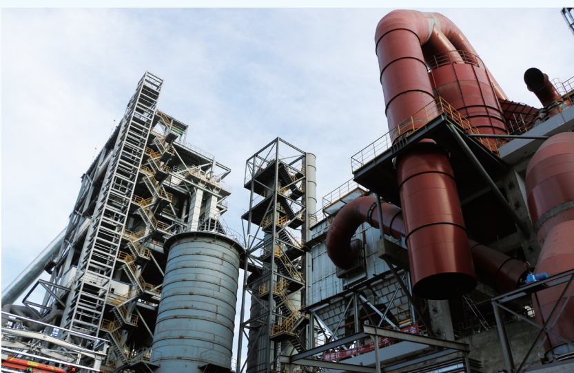
酒钢难选铁矿石资源高效利用技术改造项目一期工程悬浮炉、干法制粉主体工程。
