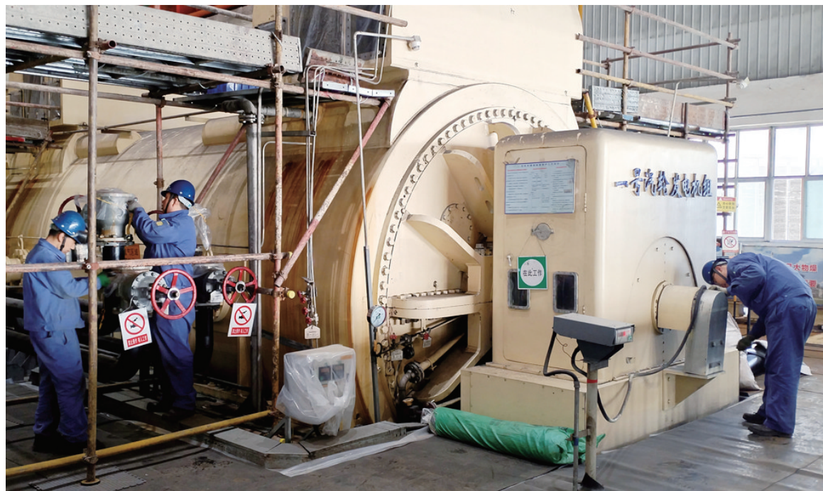
近日,宏兴电业公司开展铝电1号机组C级检修,对关键部件进行检测与维护,全方位排查机组潜在隐患,消除设备不稳定因素,确保机组高效、稳定、安全运转。李淑芳 摄
