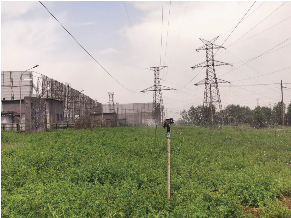
宏兴股份储运部嘉北原料作业区日前全面启动打水抑尘以及绿化带灌溉工作。翻车机卸却物料进行干雾抑尘,料场区域重点物料进行高压水枪打水抑尘,洗车装置对过往车辆进行冲洗以防带扬尘,有效抑制粉尘扩散。
