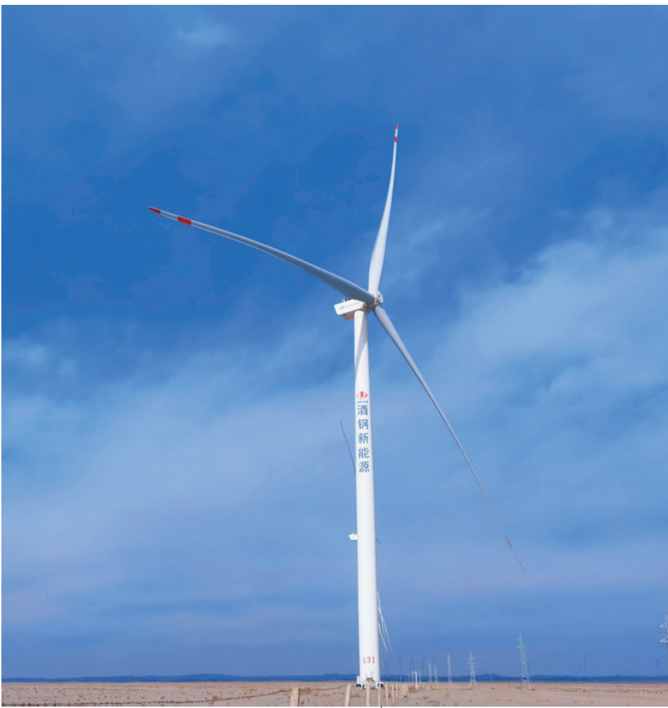
宏电热公司新能源作业区日前对红柳泉风电场风机塔筒进行全面清洗。清洗作业使用环保可生物降解清洗剂，清洗后有效提升了塔筒散热效率，预计单台风机日均发电量可提高2%—3%。周春宇 摄
