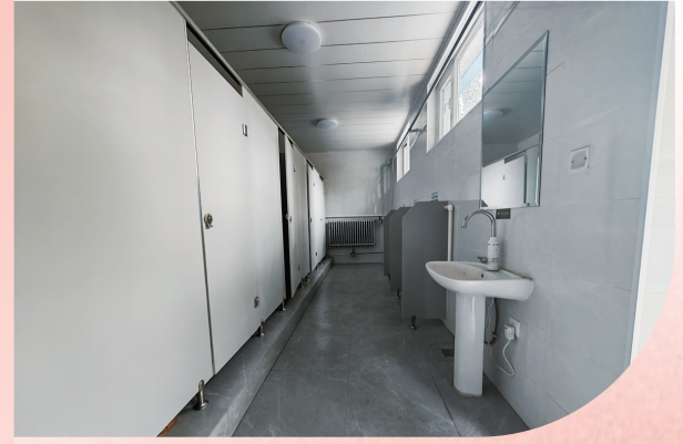
宏晟电热公司电网检修作业区分工会了解到职工对厕所改造的迫切需求，该作业区迅速行动，更换崭新的洁具，选用节水型水龙头，清理堵塞的管道，增设了物品摆放台。如今，改造后的厕所焕然一新，为职工们提供了更加舒适的工作环境。党琳 摄
