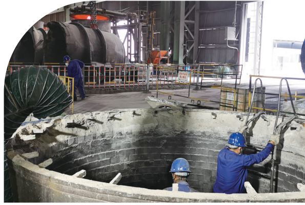
夏季钢包砌筑时，现场职工不仅承受着高温环境的考验，还面临着高温钢包炙烤。宏兴宏宇新材料公司耐材作业区工会关注职工身心健康，随着一项“包内通风降温”的实事落地，为职工送去了清凉，有效改善了钢包砌筑的作业环境。曲兰翔 摄
