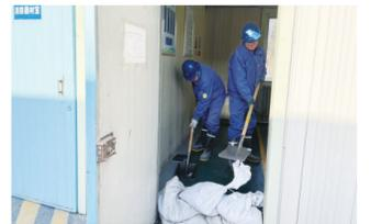
的紧急情况。演练中,各应急小组闻令而动,迅速集结。一部分人员迅速在柴油机发电室设置防汛挡板、垒砌沙袋,有效阻断外部积水倒灌。另一部分人员紧急检查区域排水系统,用铁锹等工具迅速将室内积水清理干净。整个演练过程操作规范、组织有序。通过各部门的密切配合,成功排除了险情,保障了设备安全。
