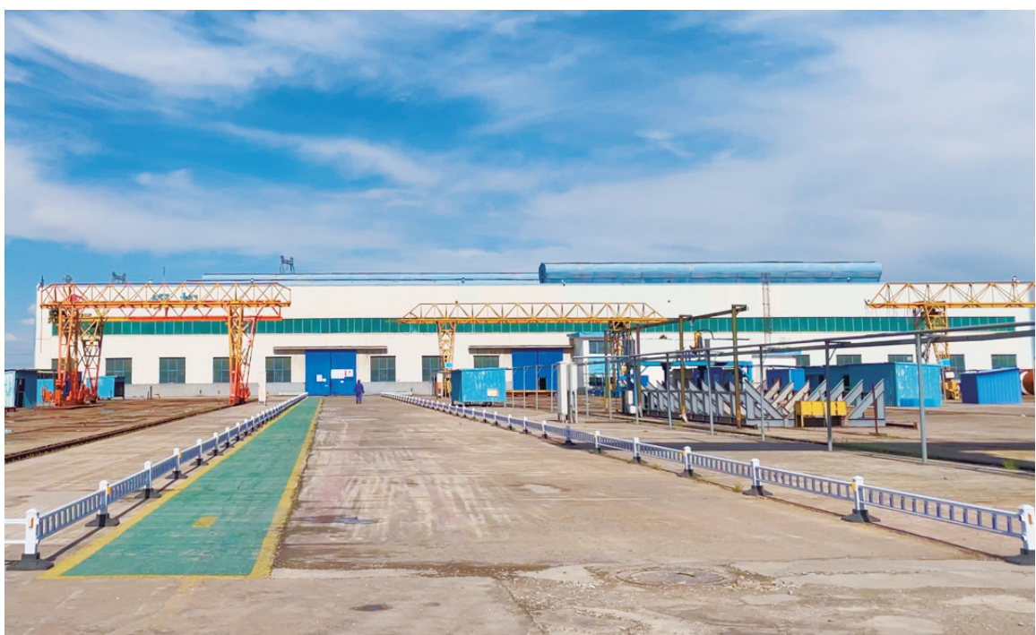
近日,工程技术公司龙泰工程公司顺利完成金结厂房安全设施改造项目,累计安装定置栏杆800余米、预埋穿线管40余处,有效实现了人车分离、线路规整和隐患消除,显著提升了现场本质安全水平。李旭文 罗兴刚 摄
