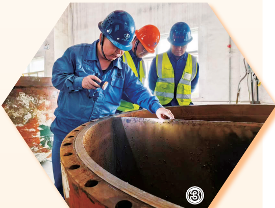
图①:350MW热网首站加热器检修后全景。 图②:检修人员开展320MW机组热网站内循环水排污门调试。
