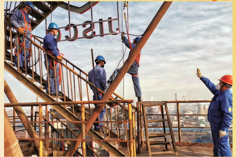
《钢铁苍穹下的守护》 张博华(工程技术公司) 摄
