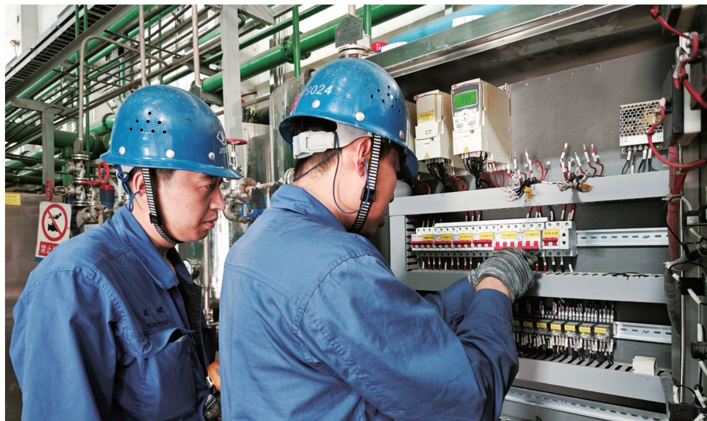
近日,宏兴热电公司热力保障作业区打响精益检修攻坚战,严把安全、质量、进度关,全力做好检修过程管控。目前3号炉、1号鼓风机等重点检修工作已全部完工,为1号高炉稳定运行、锅炉排放参数达标及机组安全稳定运行奠定坚实基础。彭啸 摄
