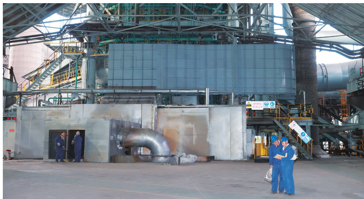
图为改造后的2号高炉前出铁平台。张立志 摄
