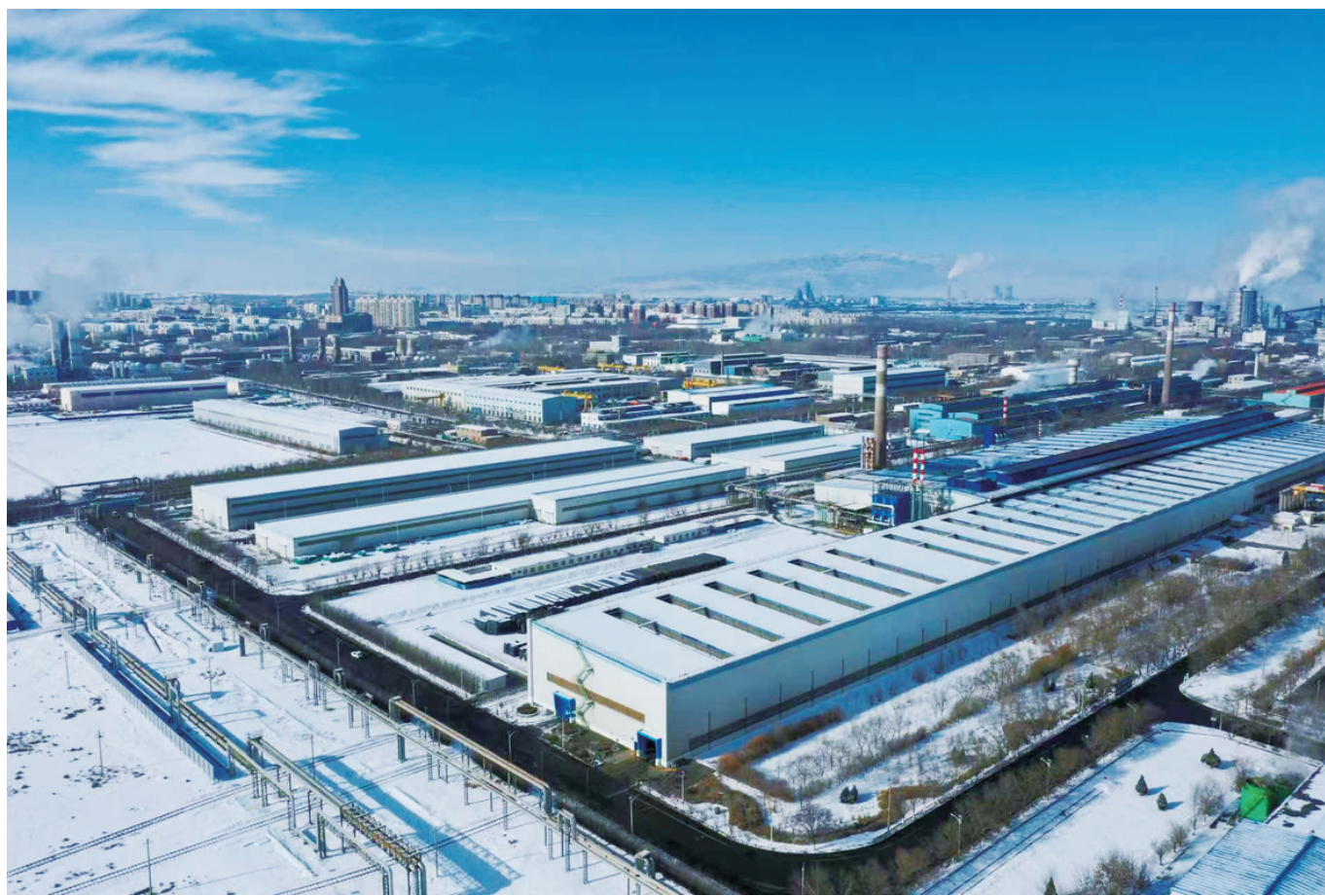
忽如一夜春风来,千树万树梨花开。近日,一场冬雪悄然而至,为雄关钢城披上银装。皑皑白雪覆盖下的酒鋼冶金厂区,绽放出别样魅力。图为大雪过后、天气放晴的酒鋼厂区一角。 张志方 摄
