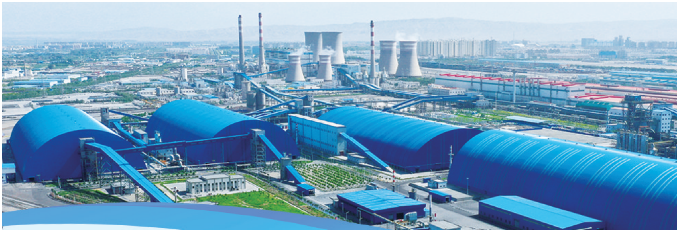
借运部嘉东料场绿色智能化改造项目全景
