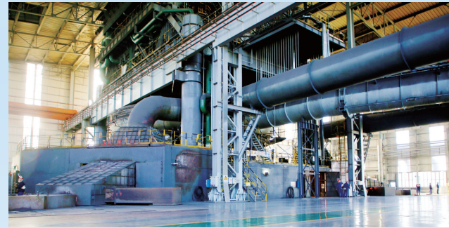
新3号高炉现场
