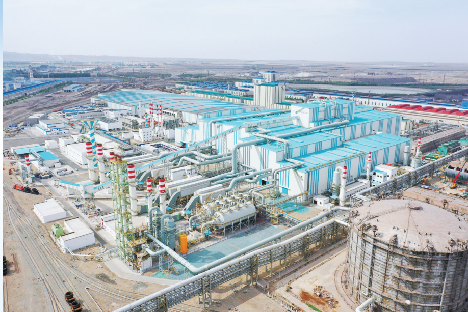
炼轧厂工艺装备提升及产品结构调整项目全景
