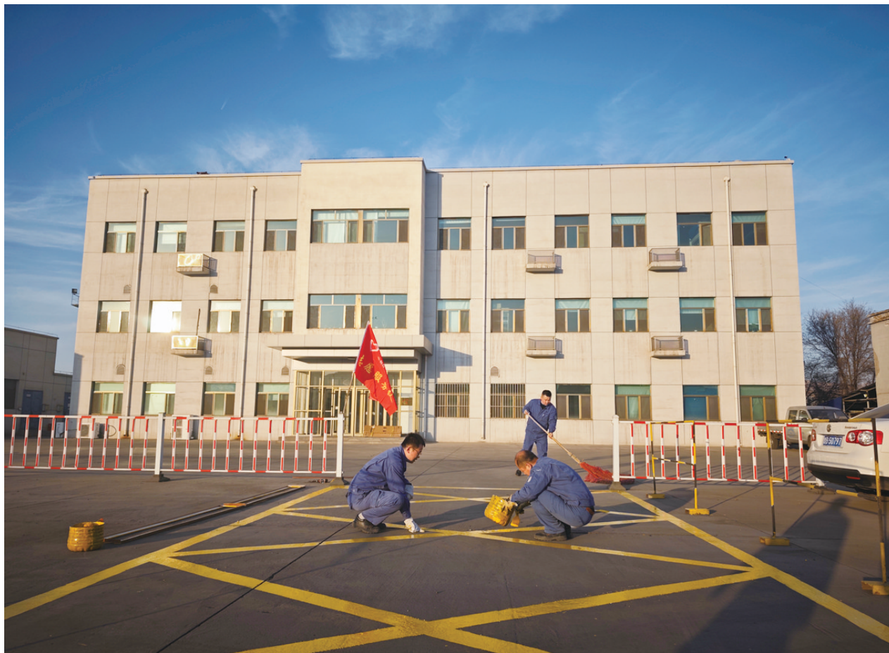
近日,检验检测中心榆钢检验检测党支部对检验楼前人行通道标线、车辆禁停线重新进行设计和涂刷,使标线整洁清晰、醒目美观,有效规避了安全风险,为职工安全出行提供坚实保障。 宋建超 摄
