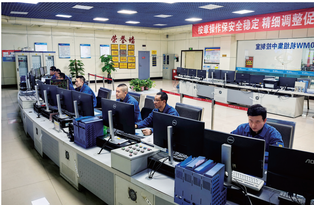
近期,宏兴热电公司热电生产二作业区积极应对低温天气,根据热网负荷与生产用能需求,精准调节机组出力与供热阀门开度,严控供热系统的压力、温度、流量等核心参数,平衡供热与发电生产的资源分配,确保热源稳定输送与生产系统高效运转。图为热电生产二作业区320MW机组集控室。李俊雅 摄
