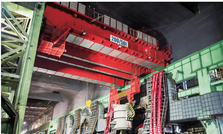
历经一个多月的安装调试与操作测试,宏兴宏宇新材料公司炼钢作业区全升级的200吨14号冶金吊顺利投入生产,助力稳产高产。王顺 摄
