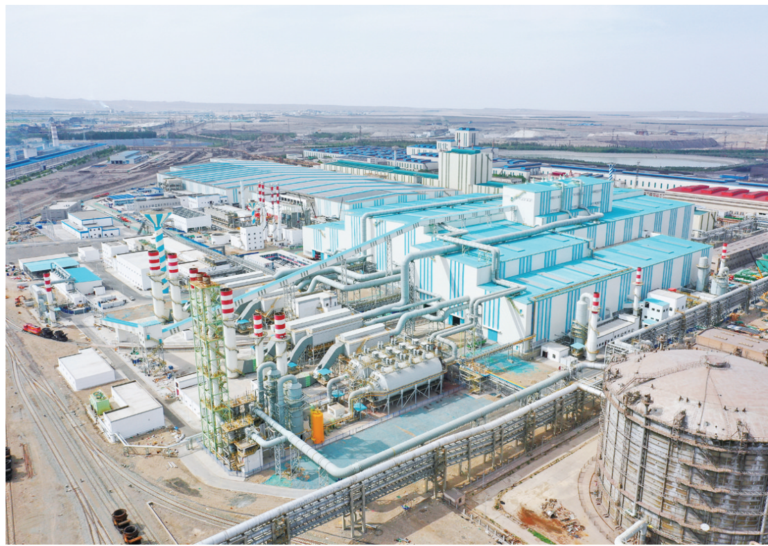
炼轧厂工艺装备提升及产品结构调整项目(资料图)。
