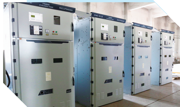
宏联自控公司智能高压配电柜。
