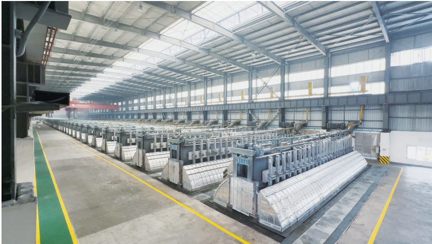
图为陇西分公司400kA电解铝生产现场。
